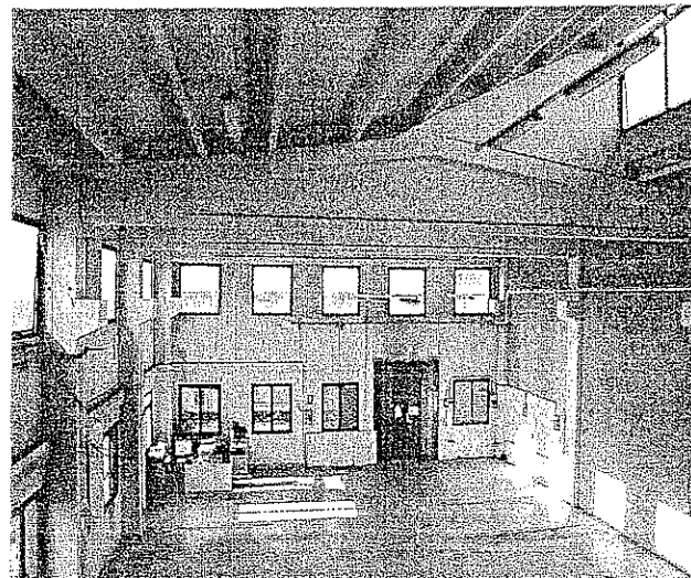
– Foto 2 – interni dal soppalco
